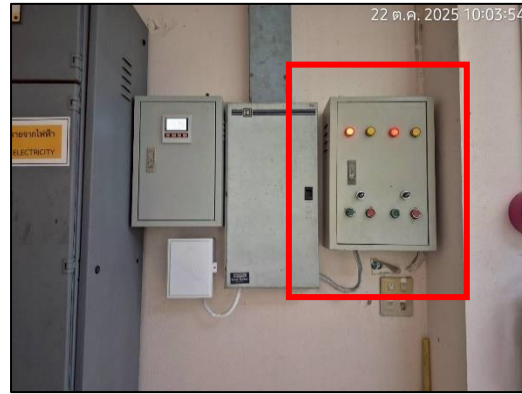
ภาพที่ 20 แผงควบคุมระบบสัญญาณแจ้งเหตุเพลิงไหม้
